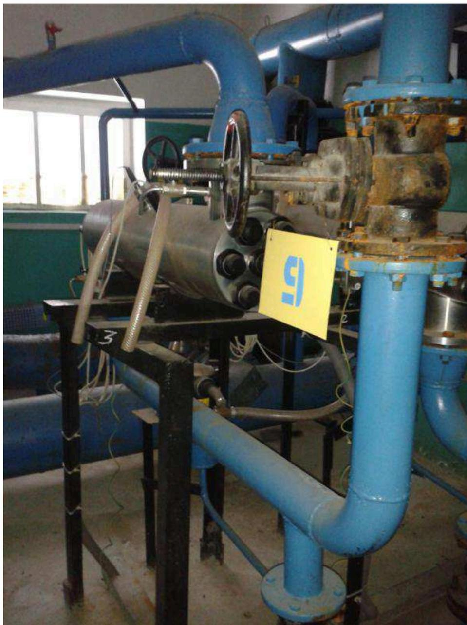
Рис. 1.4.5. Установка бактерицидной обработки воды Сергушкинского водозабора № 2
