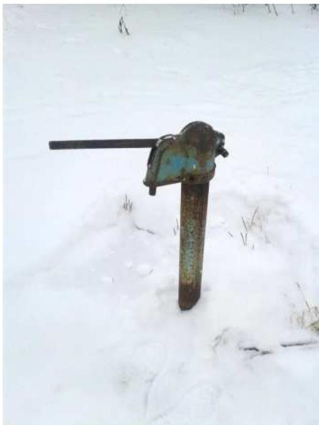
Рис. 1.2.1. Фотография водоразборной колонки, используемой в частном секторе
