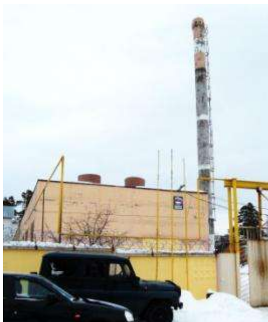
Рис. 1.1.4. Внешний вид котельной Звениговского городского молочного комбината
