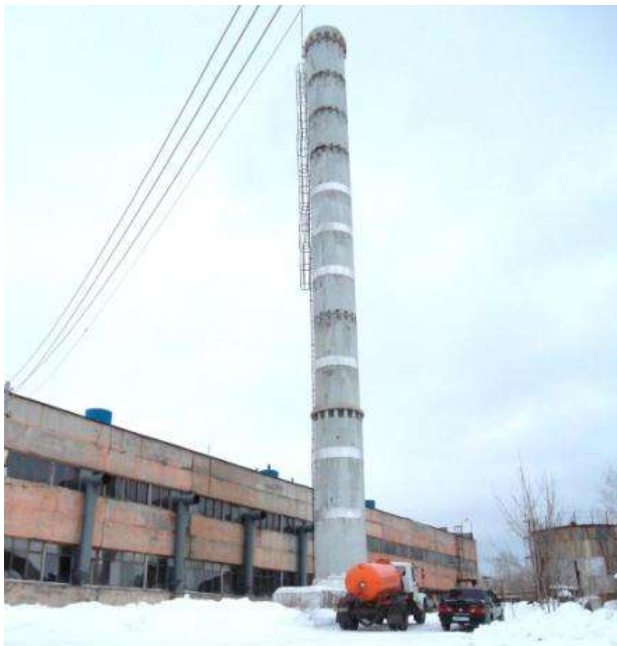
Рис. 1.1.2. Внешний вид котельной № 0614
