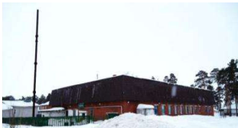
Рис. 1.1.5. Внешний вид котельной бани поселения
