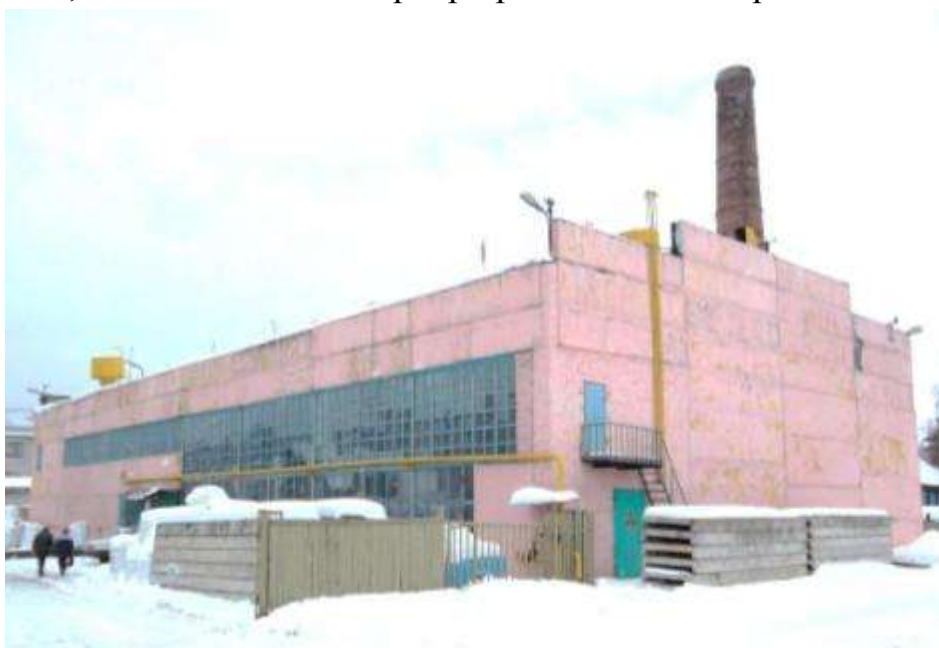
Рис. 1.1.1. Внешний вид котельной № 0601
