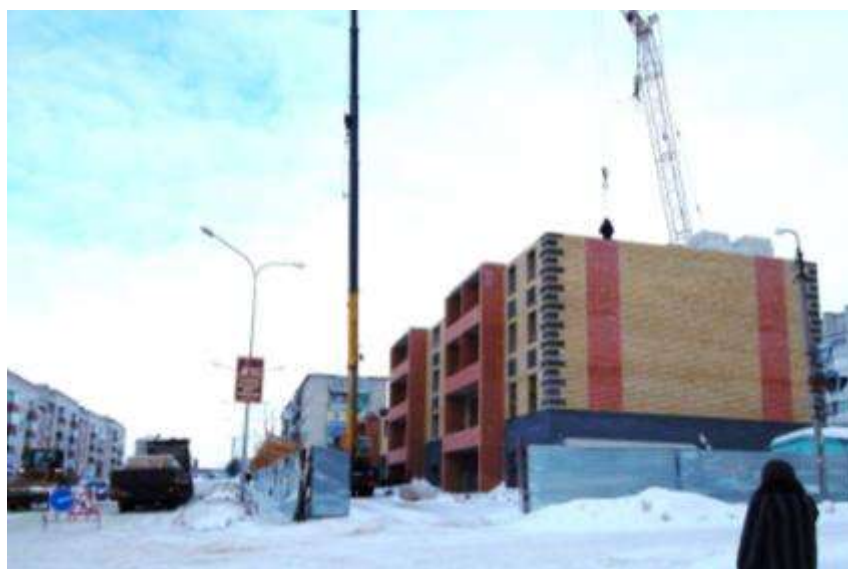
Рис. 2.3. Строительство нового жилого дома с поквартирным отоплением
