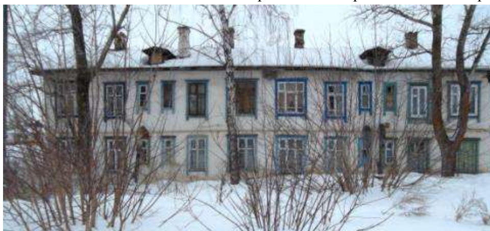
Рис. 2.2. Жилой дом «под снос» по адресу ул. Пушкина, 28
