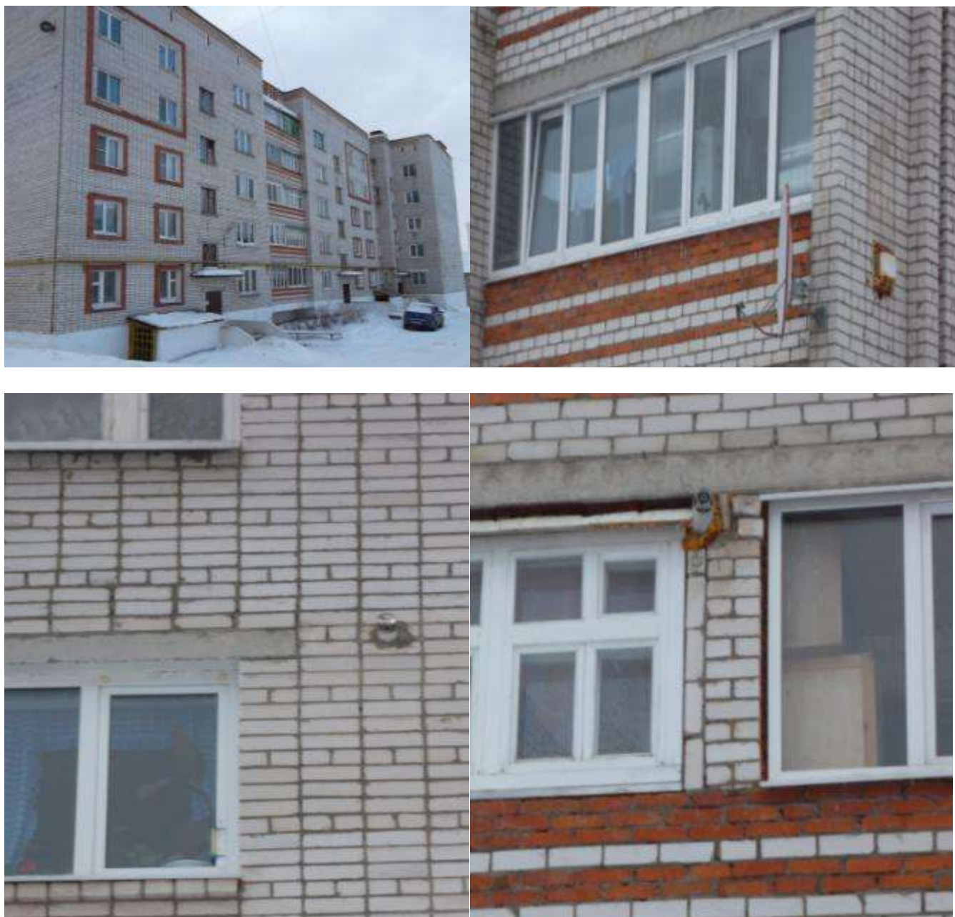
Рис. 1.1.7. Внешний вид жилого многоквартирного дома с поквартирным отоплением (Гагарина 13)
