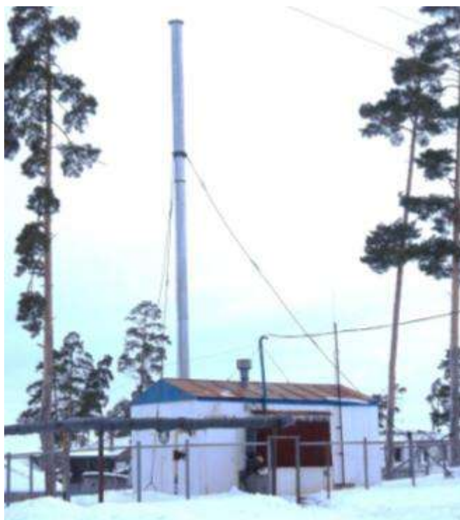
Рис. 1.1.3. Внешний вид котельной № 0615
